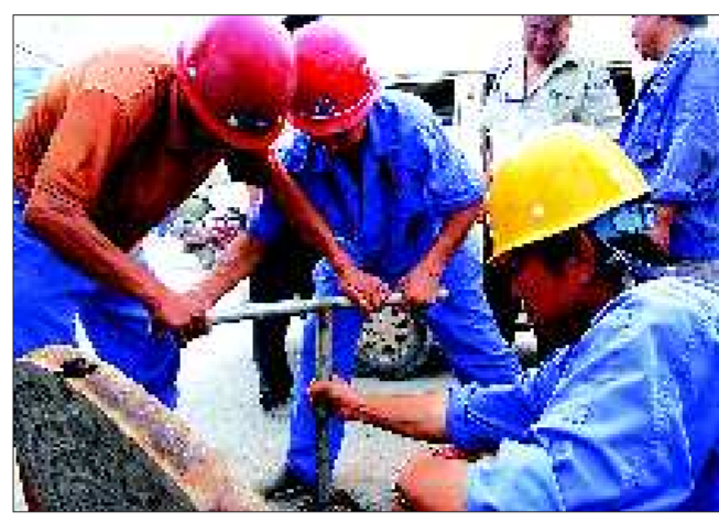
▲经过紧张施工,大部分小区提前恢复供水。本报记者 赵伟 摄
