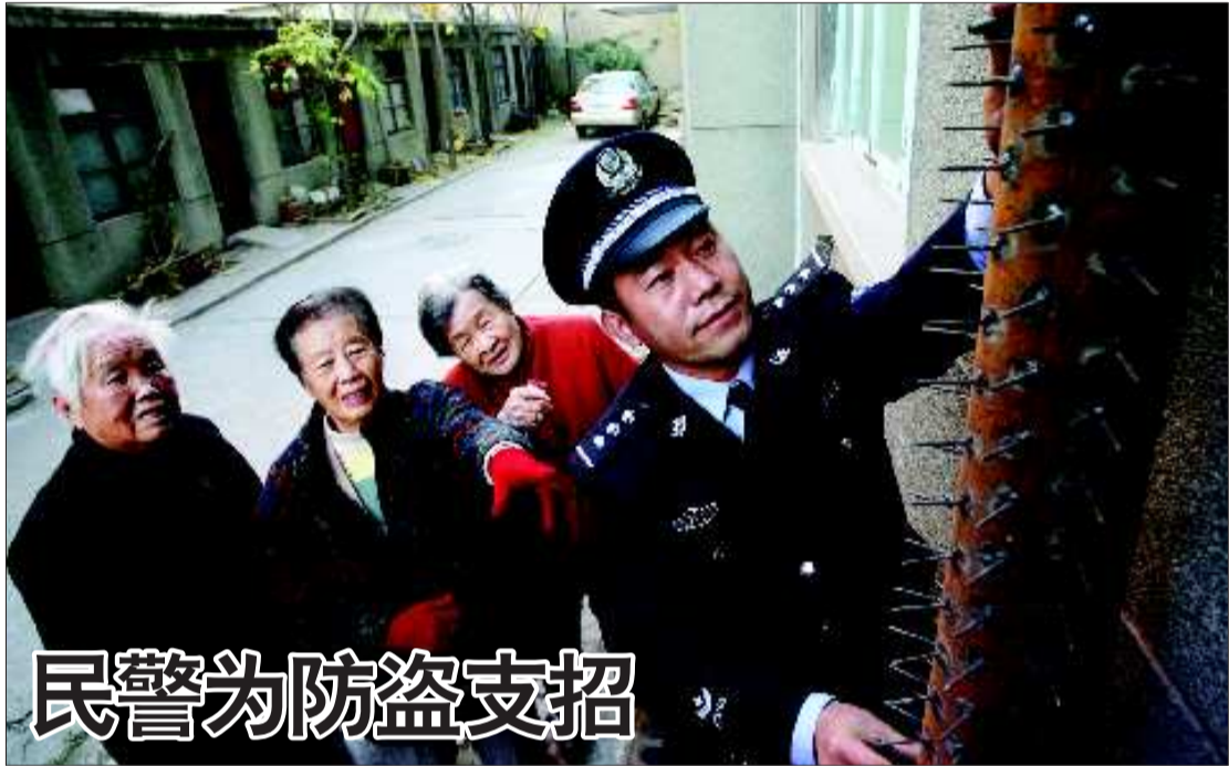
8日,在潍坊市松园子社区,城关派出所的民警正在为居民安装防盗装置。为了避免入室盗窃案件的发生,城关派出所的民警为辖区内的居民楼安装防盗刺。为防止小偷顺着管道攀爬入室,防盗刺安装在居民楼的雨水管道和窗台上。本报记者 孙国祥 摄影报道
