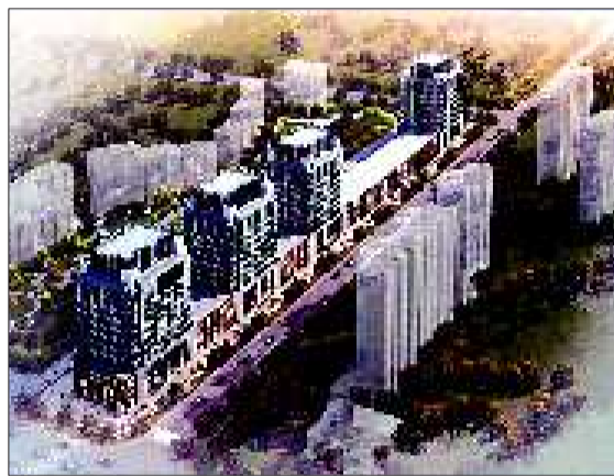
正在建设中的公租房片区沁园新居效果图。
