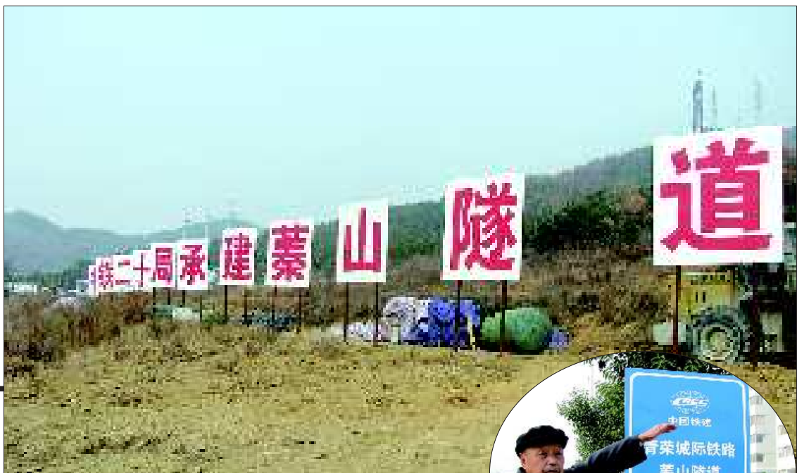
▲秦山隧道起点处。本报记者 张琪 摄
