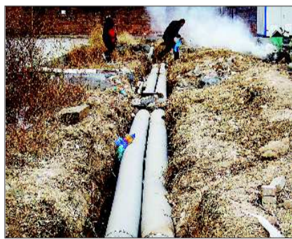
11月21日,德州的供暖季已于本月15日正式开始,21日,东厂庄园小区内的供暖管道仍然没有铺设完成,影响到了供暖的正常进行。本报记者 马志勇 摄
