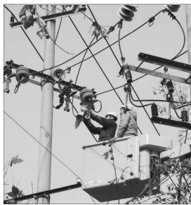
施工人员正在用绝缘布包住部分高压线。 本报见习记者 李璇 摄
