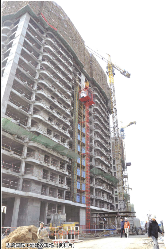
志高国际工地建设现场。(资料片)
