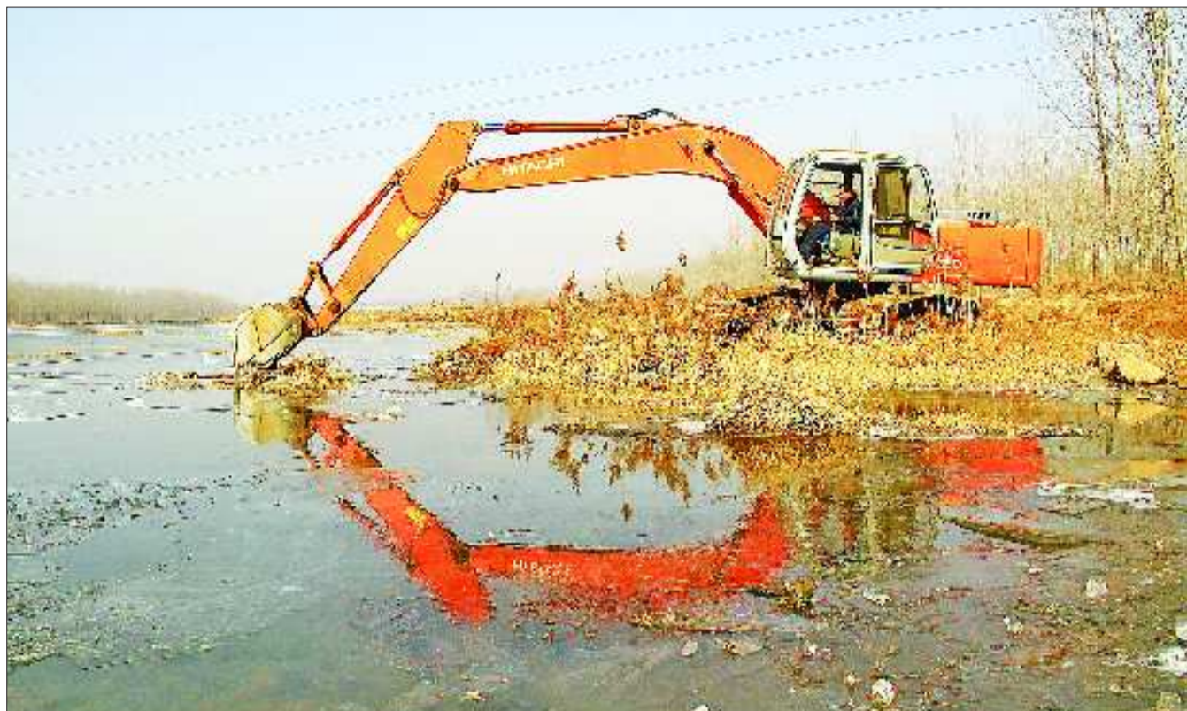
▲在鹅庄水源地,一台挖掘机正在挖掘河内淤泥。
