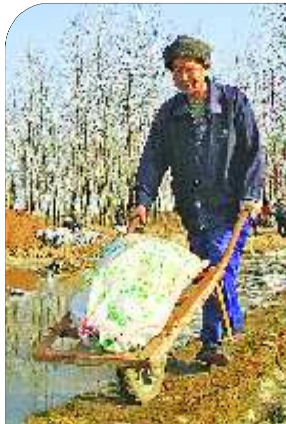
▲推运沙土提高拦河坝蓄水量。
