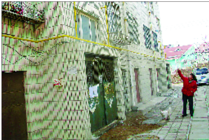
污水排了一地。
