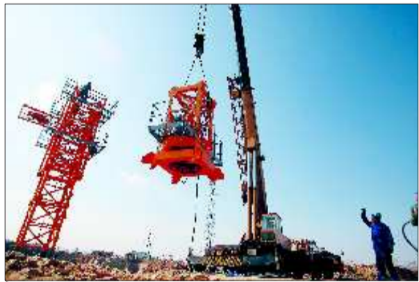
工作人员正在安装塔吊。本报记者 赵金阳 摄
