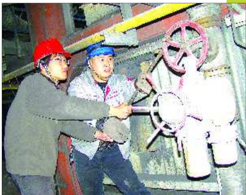
▲张伟(左)跟师傅一起检修锅炉。
