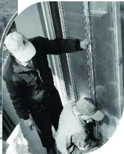
图为工作人员拆除玻璃门 见习记者 杨林 摄
