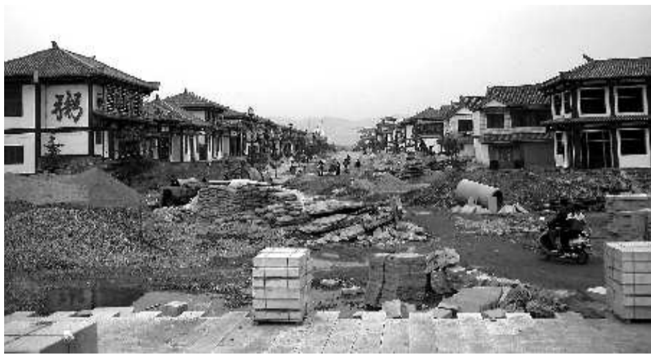
2009年4月,正在建设之中的沂南县诸葛亮文化广场。(资料片)
