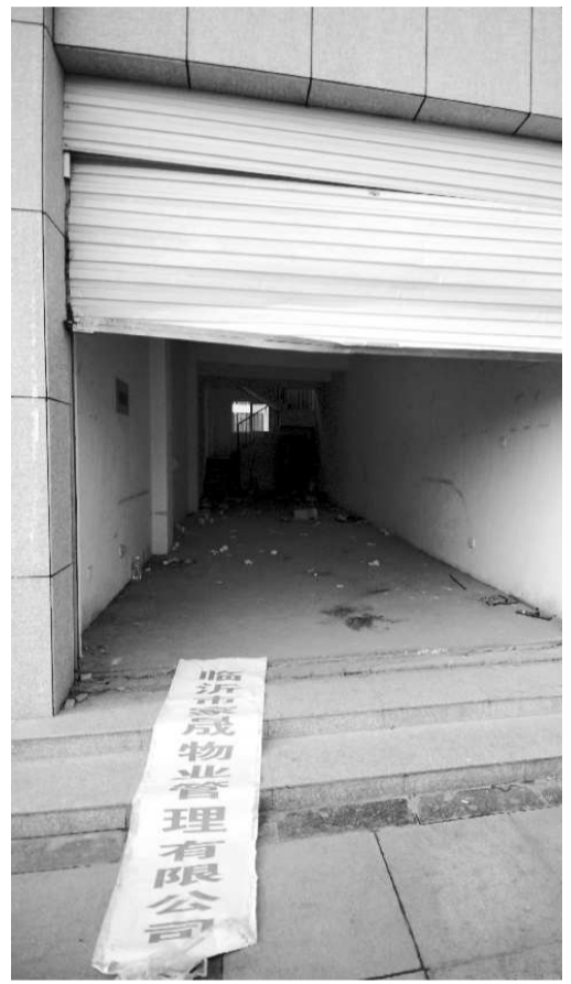
事故发生后，物业公司人去楼空。
