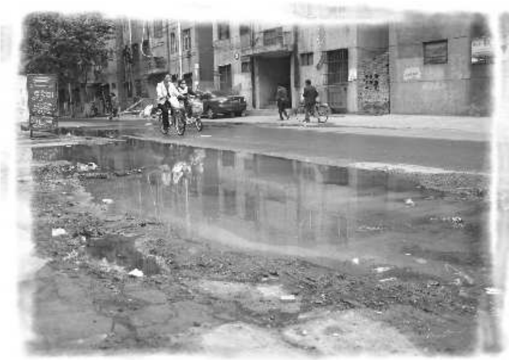
◀由于污水不停冒出,已经形成了污水洼。
