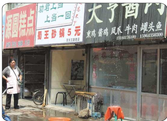
楼上阳台流水 楼下店成水帘洞
