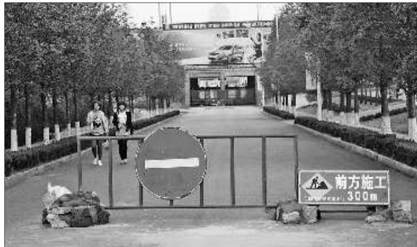
11日下午,在海曲东路与文登路交会处,施工现场北侧立着一块写有“前方施工,请绕行”的牌子。见习记者 冷炳豪 摄
