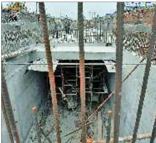
地下综合管线走廊的建设能力避道路维修“开膛破肚”。 本报记者 郭建政 摄
