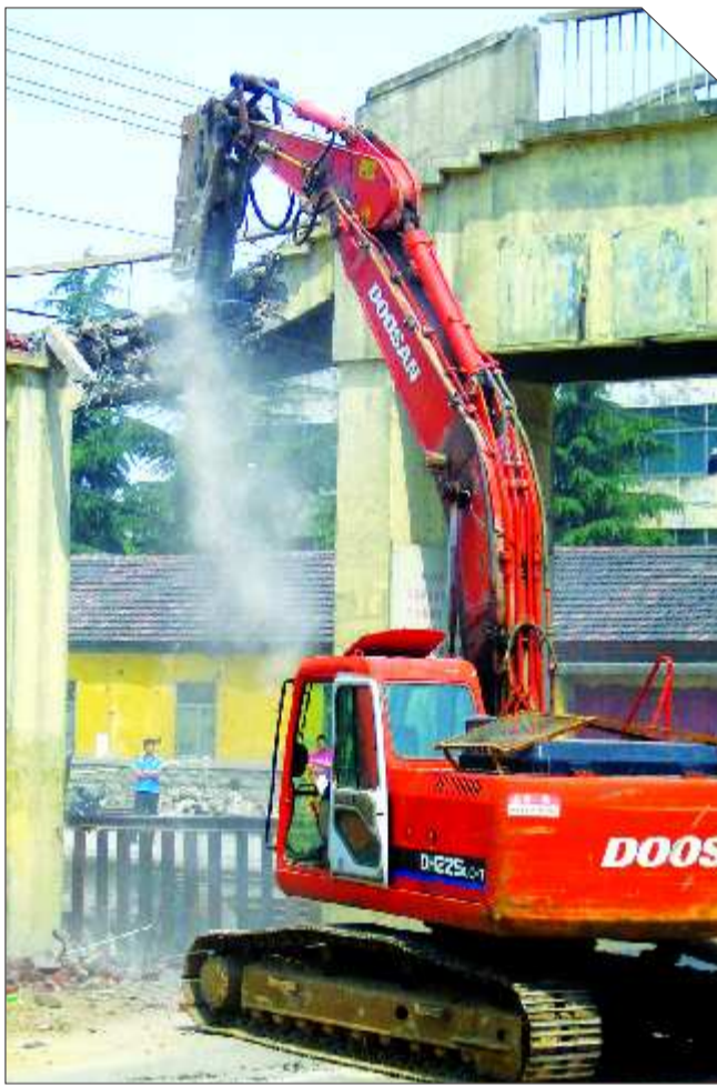
10点15分,施工车辆开始施工。见习记者 袁沛民 摄
