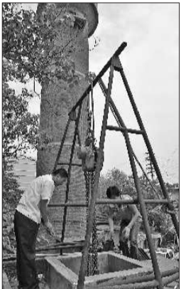
工作人员用三脚架将管道拔出。 本报记者 刘守善 摄
