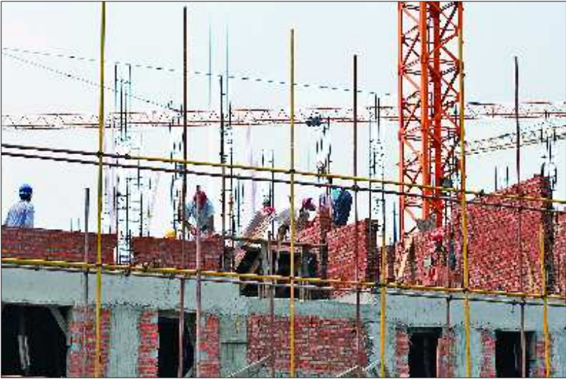
大多数楼盘在紧张建设中。
