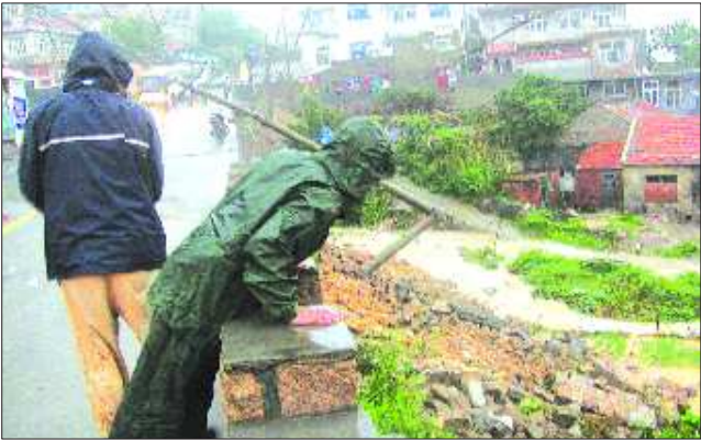
洪水冲垮路基,电线杆歪倒,一辆摩托车坠入深谷。 刘海青 摄
