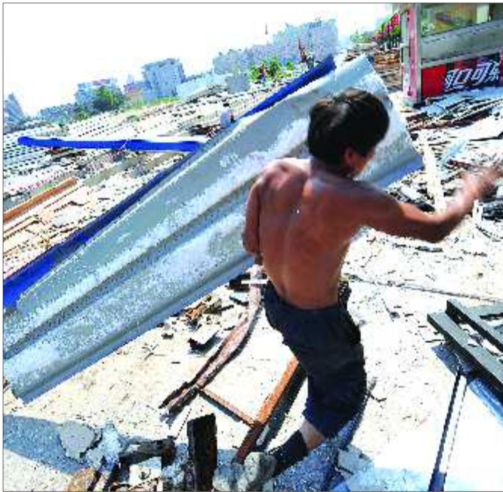
8日,泉城路东头的拆除工作进入尾声,工人们顶着烈日搬运板材。 本报记者 陈文进 摄
