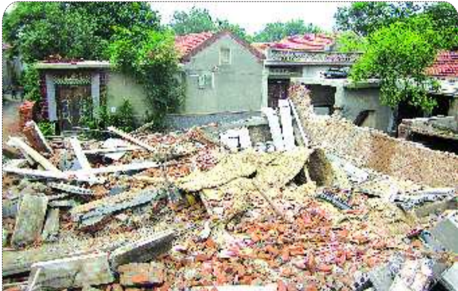
刚建好的房子已经完全坍塌。 本报记者 刘德峰 摄
