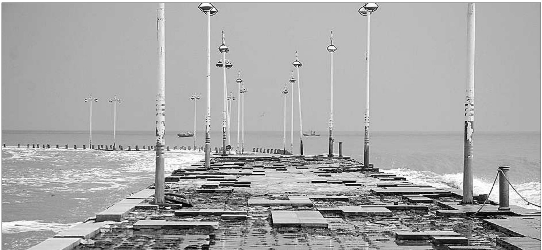
▲8日,在灯塔广场景区,长长的栈桥铺设的大理石被巨浪掀掉了许多。 记者 张照朋 摄
