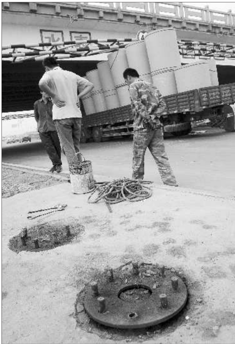
限高架被撞后,从固定处脱离向南移动了10多米。 记者 刘海蒙 张希文 摄
