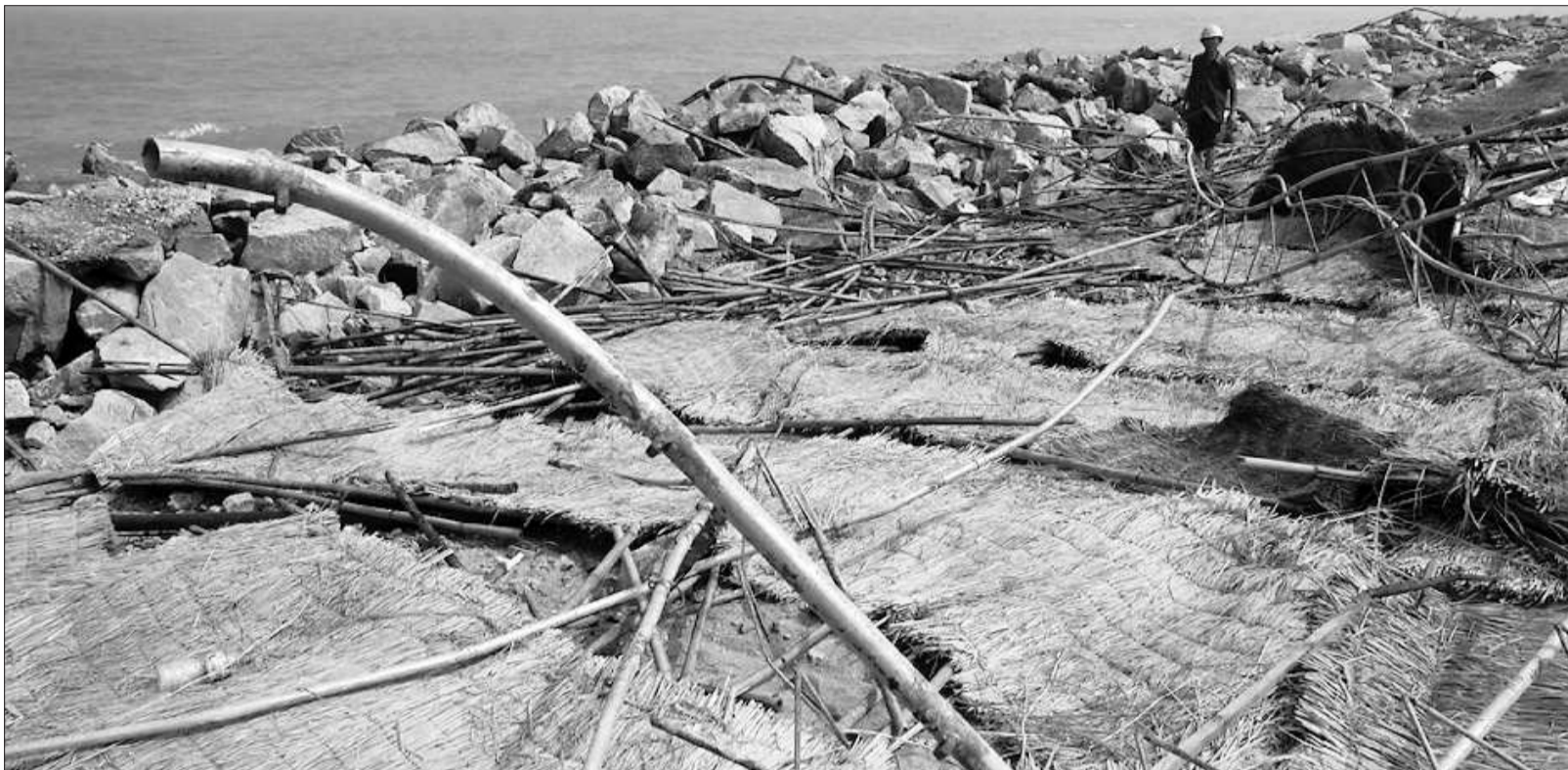
海参养殖大棚被冲垮,钢架散落一地。
