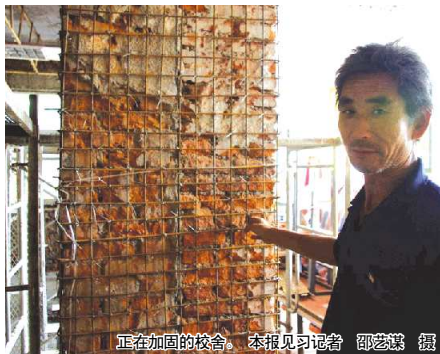
正在加固的校舍。 本报见习记者 邵艺谋 摄
