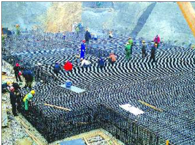
▲超高密度钢筋确保坚实的基础。
