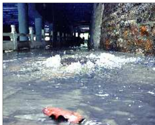
青龙桥涵洞附近的污水井盖“冒顶”了。 本报记者 任志方 摄
