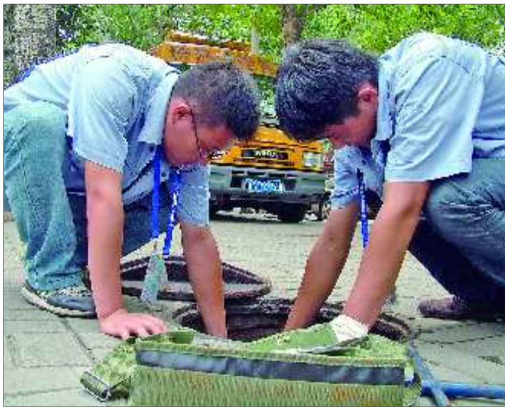
供热间歇期,供热企业济南热电有限公司技术人员正在进行管道检修,维护热阀门。 本报记者 王鸿光 摄
