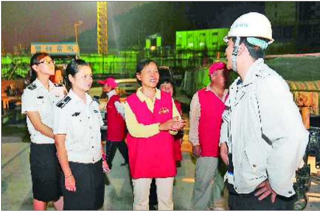
百姓城管队员和执法人员一起在工地与负责人交谈,随后施工方停止了夜间作业。
