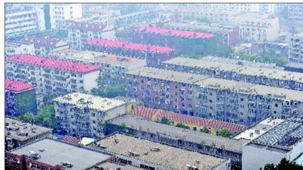
23日,高处俯瞰历城区招待所片区现状。
