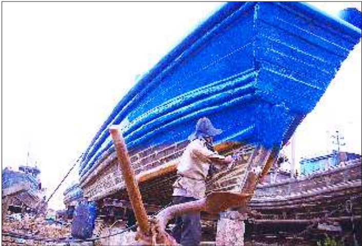
23日,在金家沟码头,船工给船身喷防腐漆。
