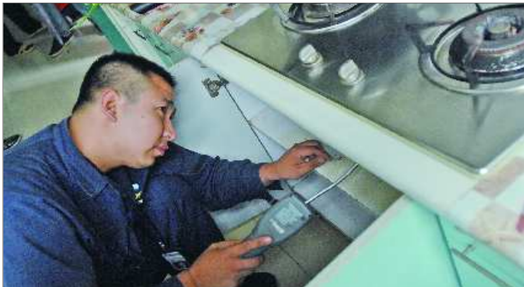
燃气置换过程中,济南港华检修人员入户检测设备安全。 本报记者 戴伟 摄
