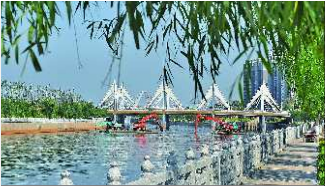
小清河越来越靓丽,挖掘机正在清淤。 本报记者 陈文进 摄
