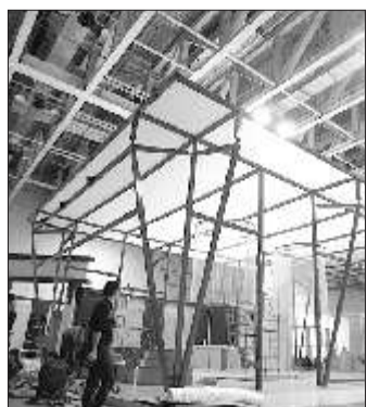
葡萄酒厅各个展区框架已基本完成。
