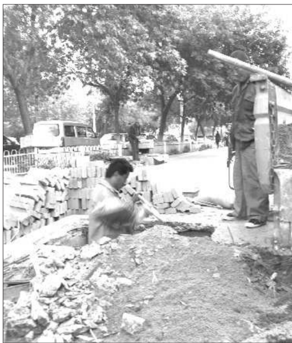
工人师傅正在胶州路嘉士利蛋糕店门口补装井盖。本报记者 李金金 摄
