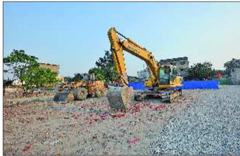
挖掘机开进改造现场。徐延春 摄
