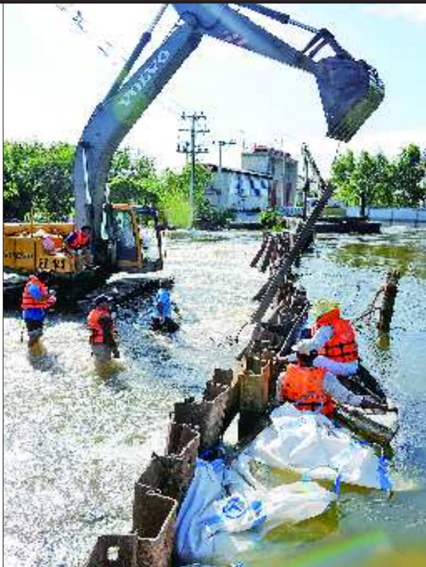
15日,抢险人员加固泰国巴吞他尼府青拉亚县班普劳村的防洪堤水闸门。新华社发
