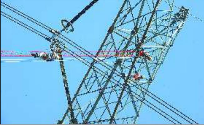
王进在距导线0.5m处,使用电位转移棒迅速挂住导线进入电场。
