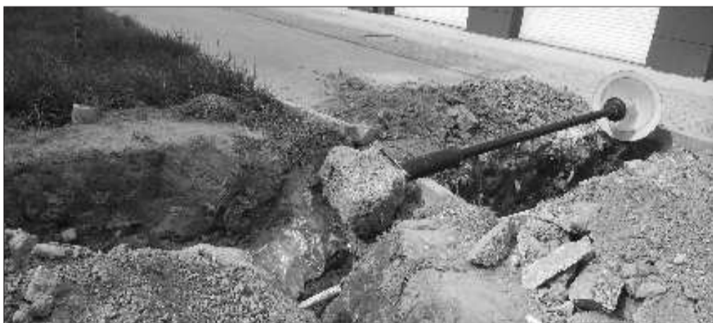
修电缆时挖开的大坑。 记者 于荣花 孙珊 摄
