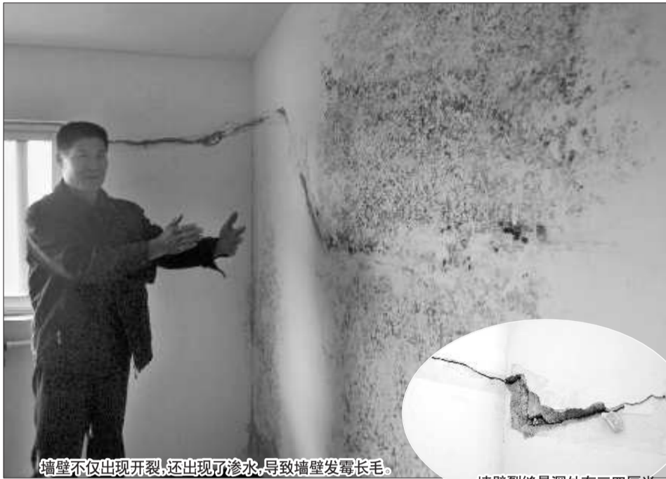
墙壁裂缝最深处有三四厘米。
