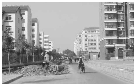
由于施工挖开路面,繁森东路只剩下东半边能够通行。 本报记者 焦守广 摄
