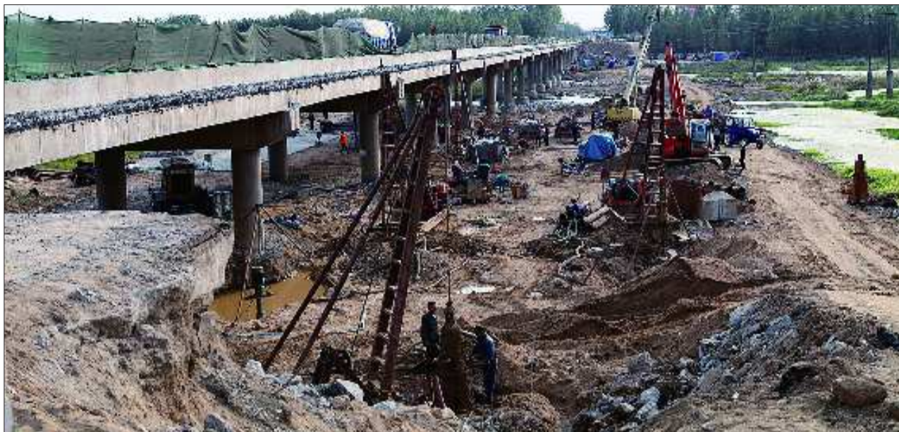
19日,付疃河大桥西侧的桥梁已经拆除,工人们正在紧张作业。 通讯员 安茂胜 摄
