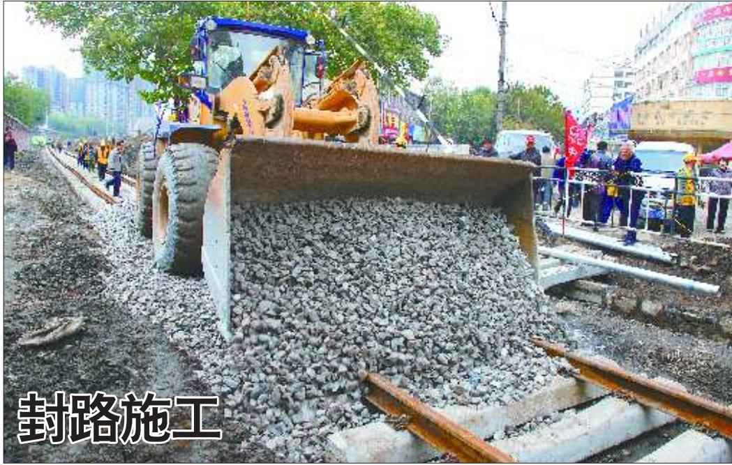
为配合枣临铁路建设,枣庄市市中区胜利路公铁平交道口自21日起封路施工,本月30日施工结束后道路将恢复正常通车。24日上午记者在该路段看到,施工现场十分忙碌,铁轨和枕木已经安装完毕。图为施工车辆正在向铁轨枕木空隙处填石子。
