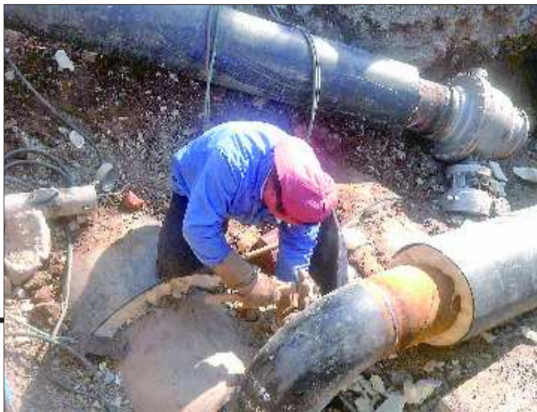
▶花园路供热管线改造,工作人员将支管线焊接到主管道上。 本报记者 王光照 摄
