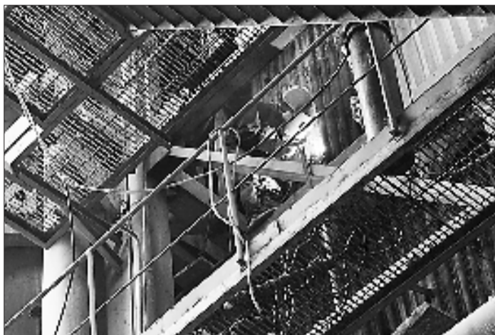
27日,日照阳光热电公司的工作人员正在检修设备。记者 冷炳豪 摄
