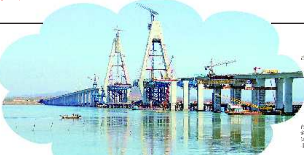
▲海即跨海大桥还有 80 米就要全线贯通。
