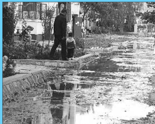
▲百余米长的污水漫过了道路, 附近居民出入很不方便。 本报记者 郑美芹 摄
